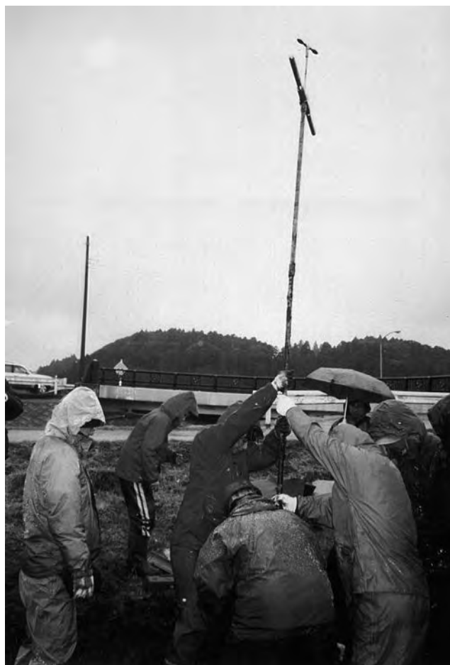
図 2 シンウォール型サンプラーによる掘削状況（写真：清永）。
