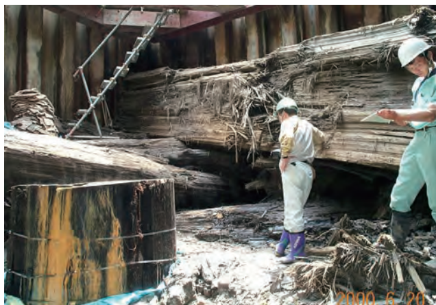
写真5 掘り出しトレンチ内部(立木と巨大流木群)。
