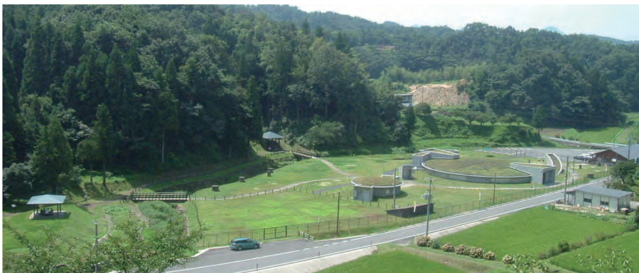
写真6 現在の三瓶小豆原埋没林公園(大小2つの展示棟のほか, 公園内の整備も終わった。立木が確認できた位置には, それぞれの太さに合わせたモニュメントが設置されている)。
